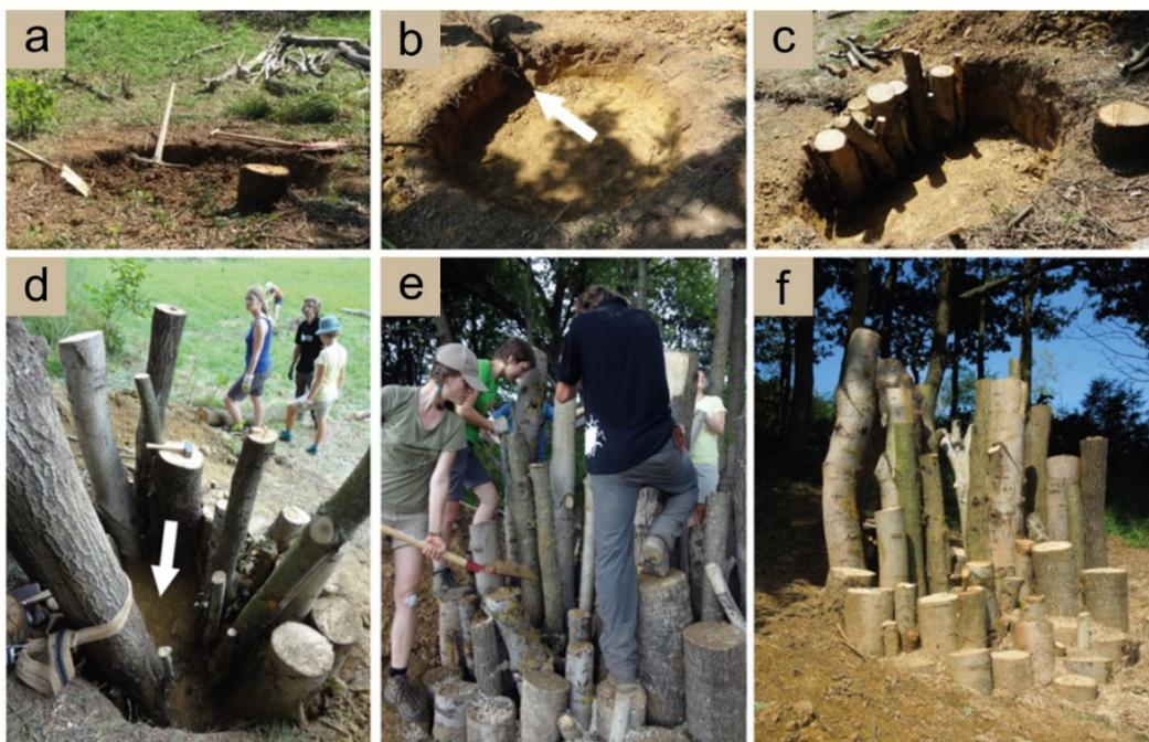
Abbildung 1. Bilddokumentation vom Bau einer Käferlarvenburg. (a) Grube ausheben, im Vordergrund der Stumpf einer alten Eiche; (b) Endtiefe der Grube erreicht und Regenwasserdrainage anlegen (weißer Pfeil); (c) Setzen der ersten Reihe kürzerer Stammstücke; (d) Zwischenstand der gesetzten Stammstücke, zentrale stammfreie Zone als Eiablageplatz und Verpuppungsort (weißer Pfeil); (e) Lücken mit Erde verfüllen und verdichten (f) Fertige Käferlarvenburg aus Eichen- und Pappelstämmen
