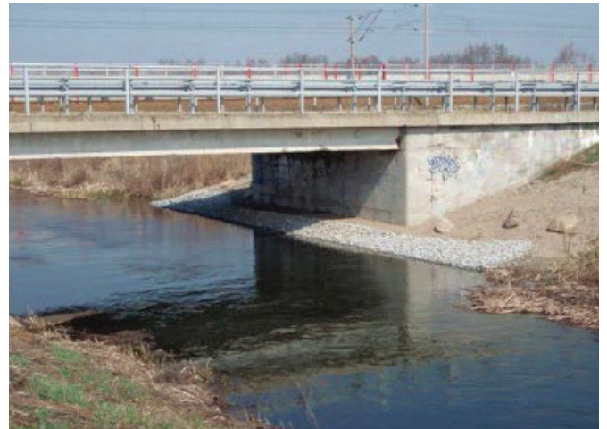
Abbildung 2. Aufdopplung einer zu niedrigen Berme mit Rollschotter (c) A. Kranz
