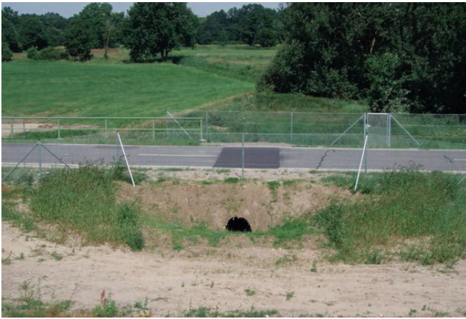
Abbildung 3. Ein Otterrohr zur Anbindung eines vom Otter häufig genutzten Feuchtbiotops (c) A. Kranz
